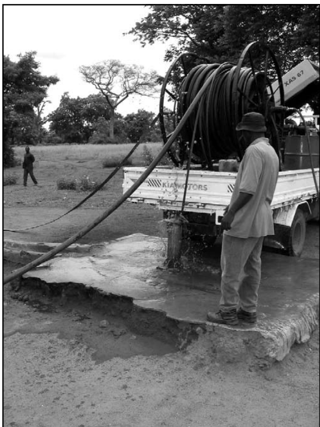
Nettoyage des dépôts sédimentaires dans un forage en cours de réhabilitation au Ghana
